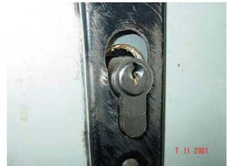
Abb. 2 . 3: Brandschutztür mit Asbestplatte im Schlosskastenbereich
