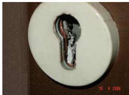
Abb. 2 . 3: Brandschutztür mit Asbestplatte im Schlosskastenbereich
